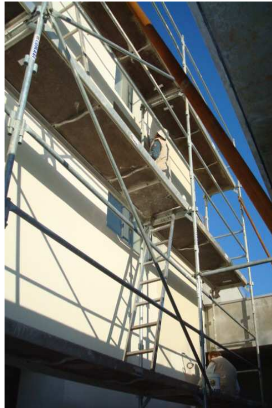
Résultat après la seconde passe de l'enduit à la chaux KEIM UNICAL 13
