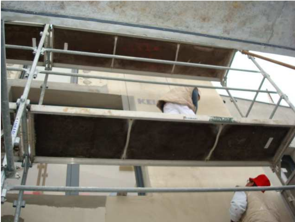
Marouflage du TREILLIS D'ARMATURE KEIM
