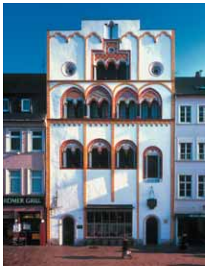
La Maison des 3 rois à Trèves : illustration de la luminosité des peintures minérales
